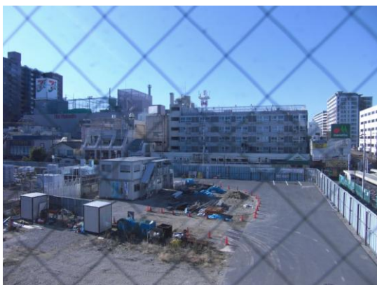
【写真2】工事中の西口駅前
